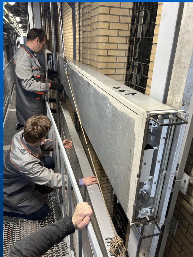
Монтаж одной ДК
